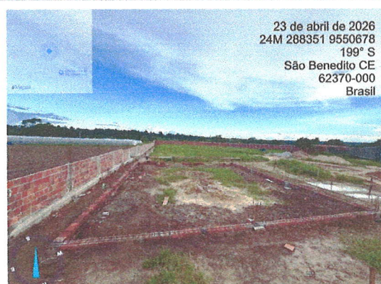
LOCAÇÃO, ESCAVAÇÃO E FUNDAÇÕES DE OBRA BLOCO B
