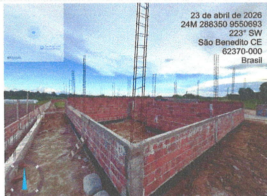
FUNDAÇÕES, ESTRUTURA E ALVENARIA BLOCO A
