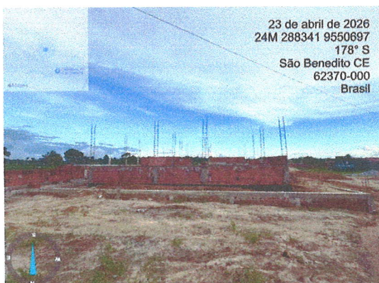
FUNDAÇÕES, ESTRUTURA E ALVENARIA BLOCO A
