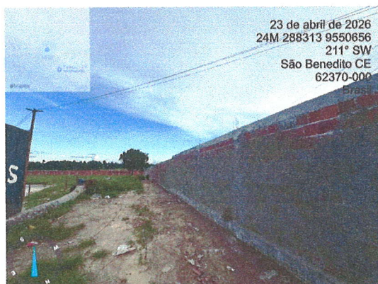
MURO DE CONTENÇÃO E MURO DE CONTORNO
