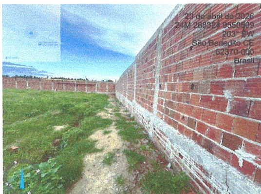
MURO DE CONTENÇÃO E MURO DE CONTORNO
