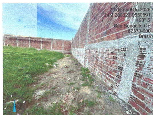
MURO DE CONTENÇÃO E MURO DE CONTORNO
