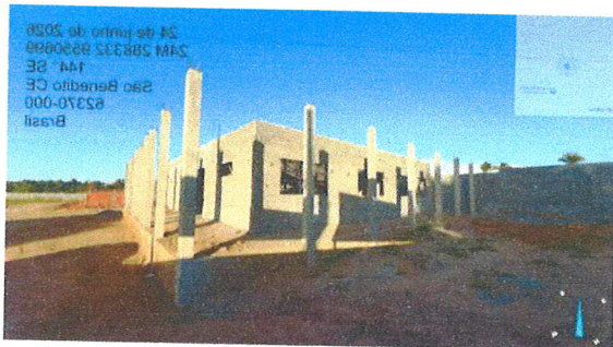
ESTRUTURA E ALVENARIA BLOCO A
