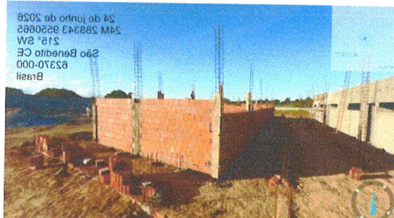
FUNDAÇÕES, ESTRUTURA E ALVENARIA BLOCO D
