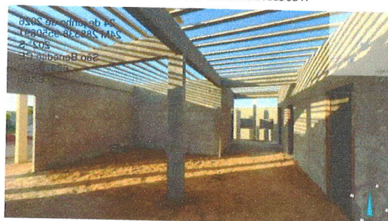
ESTRUTURA E ALVENARIA BLOCO A
