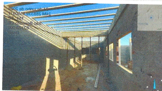
FUNDAÇÕES, ESTRUTURA E ALVENARIA BLOCO B
